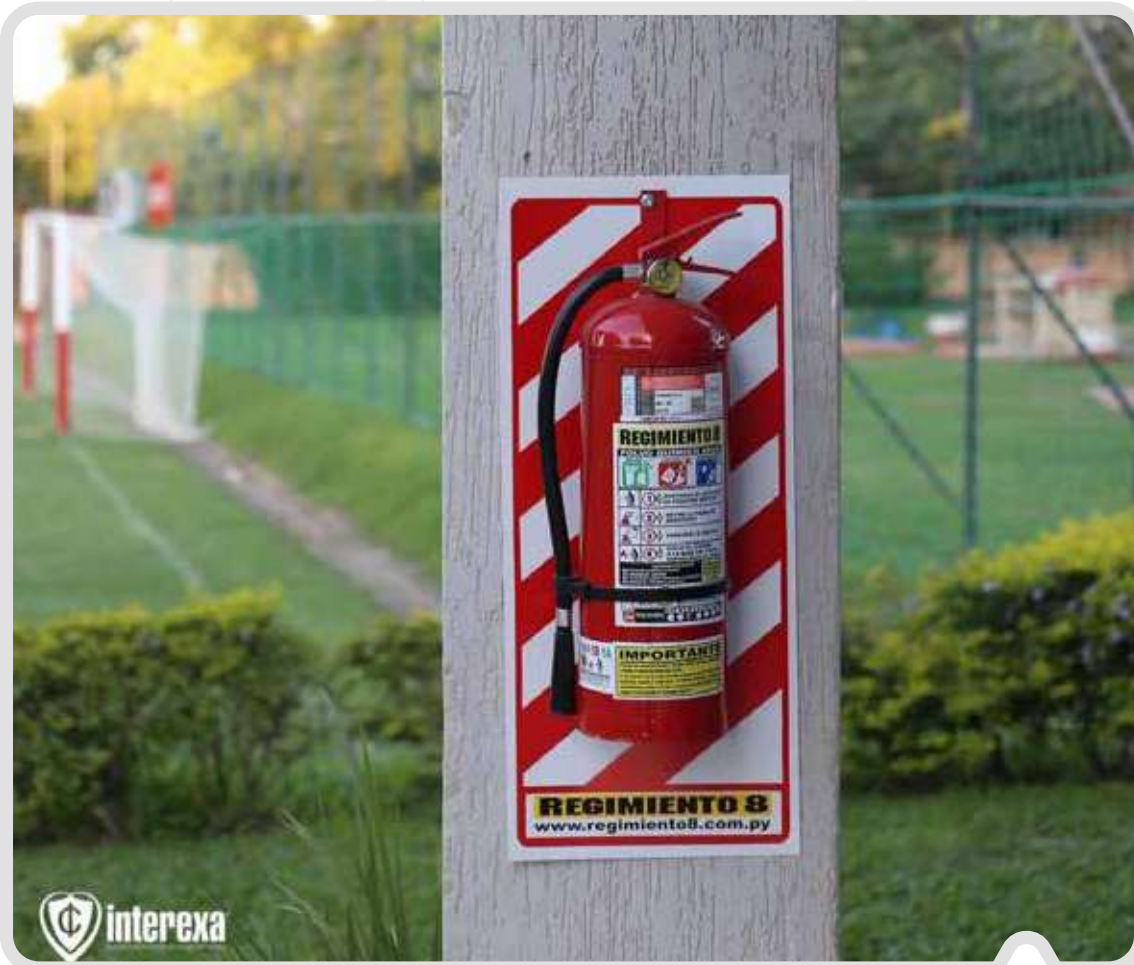
Colocación de extintores. Entrega de conos y materiales en alianza con Regimiento 8.
